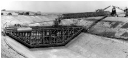
Inmediatamente después de la Segunda Guerra Mundial, G&Z se dedica al diseño y la fabricación de maquinaria de construcción de canales y suministra su primer grupo de máquinas para canales en 1947. Estas originales máquinas se utilizan en el proyecto "Grand Coulee Dam" en el Estado de Washington, el Canal Friant-Kern, y el proyecto "Delta Mendota Canal" en California. Los equipos para canales de G&Z se han utilizado para construir más del 80% de los canales del oeste de los Estados Unidos.
